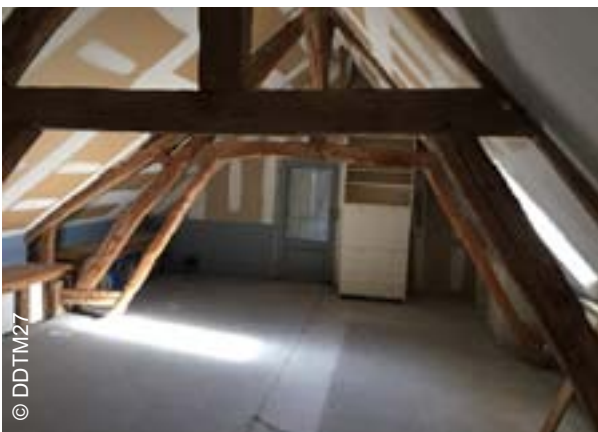
Aménagement de combles
