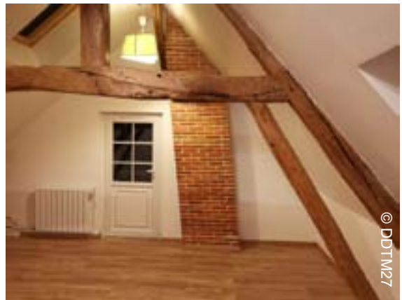
Aménagement de combles
